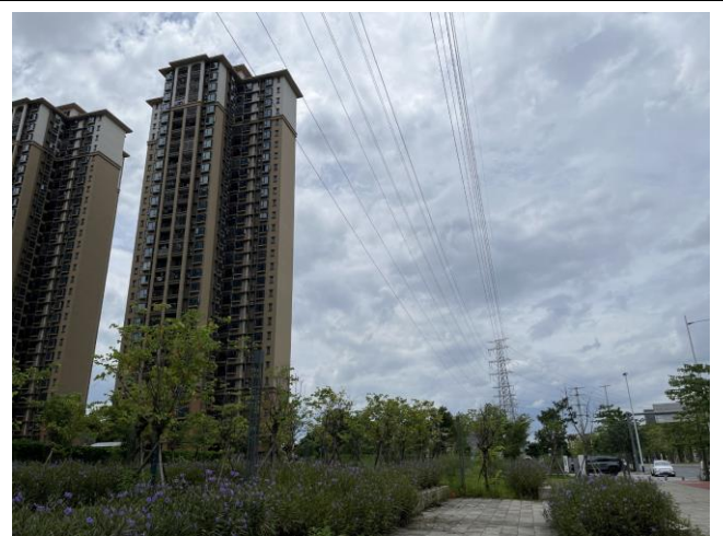
拆除塔基已恢复原有土地功能
