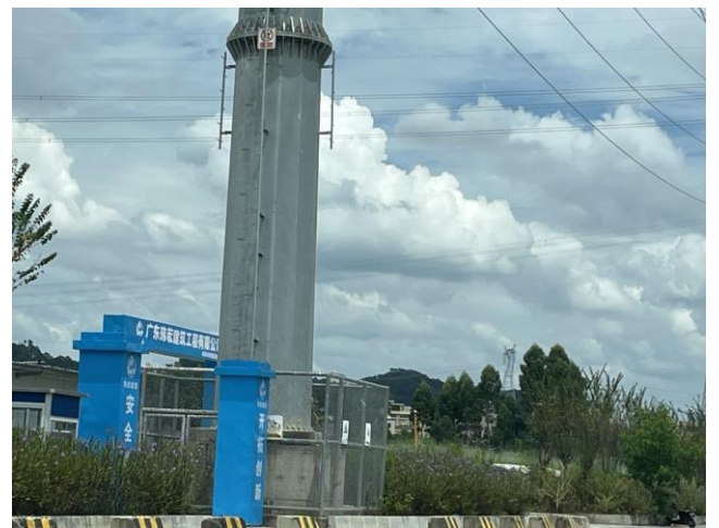
塔基占地硬化处理
