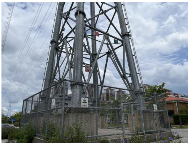
塔基占地硬化处理
