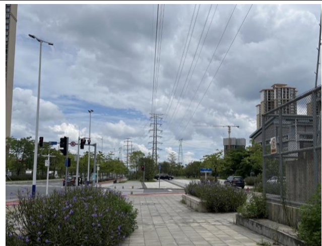
拆除塔基恢复原有土地功能
