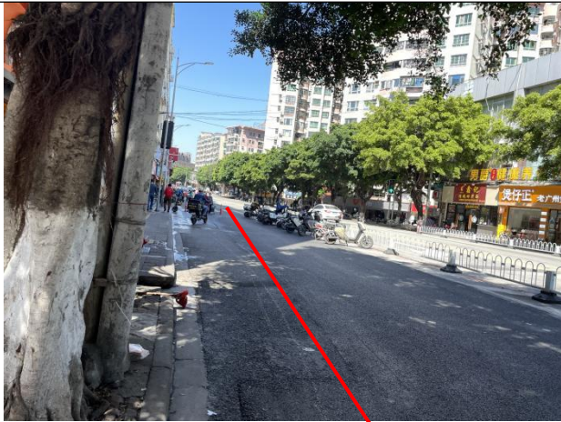
本工程电缆线路沿线-岗贝路（红线为本次新建电缆线路）
