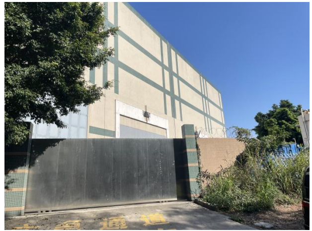
220kV 环西站扩建间隔侧
