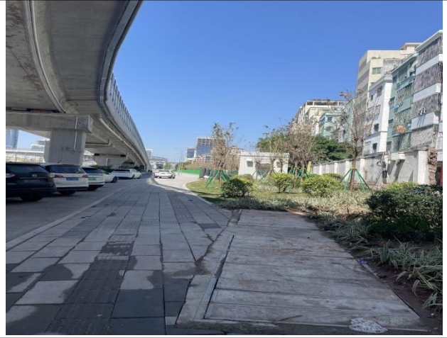
电缆线路沿线绿化恢复情况
