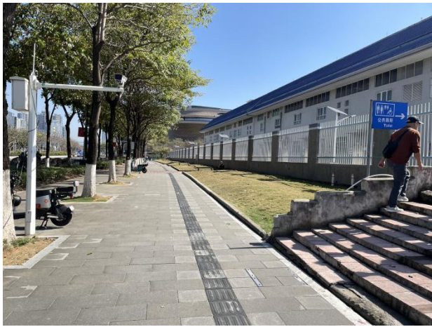
220kV 航云站扩建间隔侧
