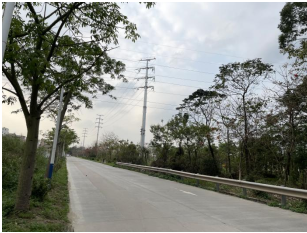
沿钟港大道架设情况
